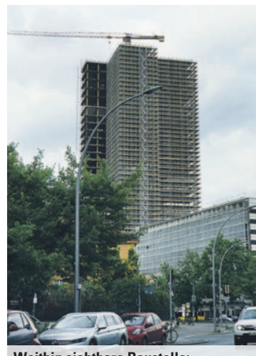
Weithin sichtbare Baustelle: der Steglitzer Kreisel
